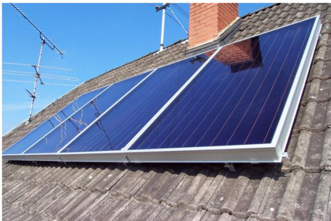
Abbildung 1: Auf Hausdach montiertes Solarmodul.
